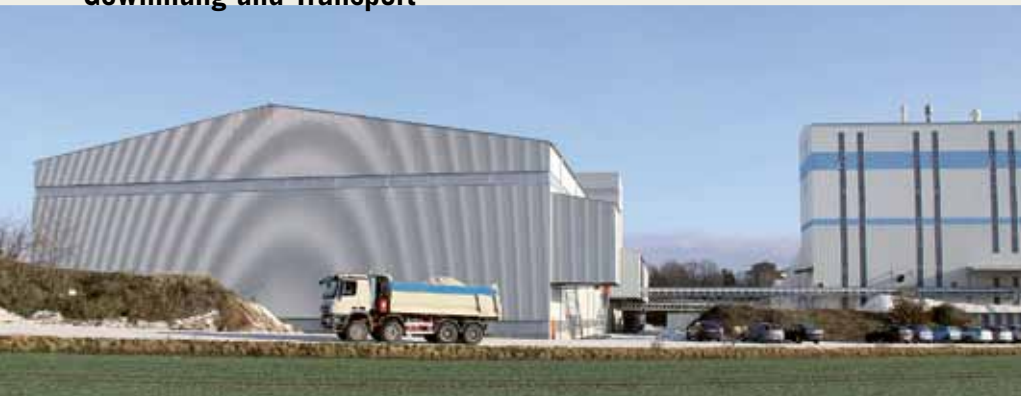
Zur Vorhaltung größerer Mengen erweiterte die Schlingmeier Quarzsand GmbH & Co. KG die Produktionsstätte um eine Lagerhalle mit der Grundfläche von 6 300 m 2 .
