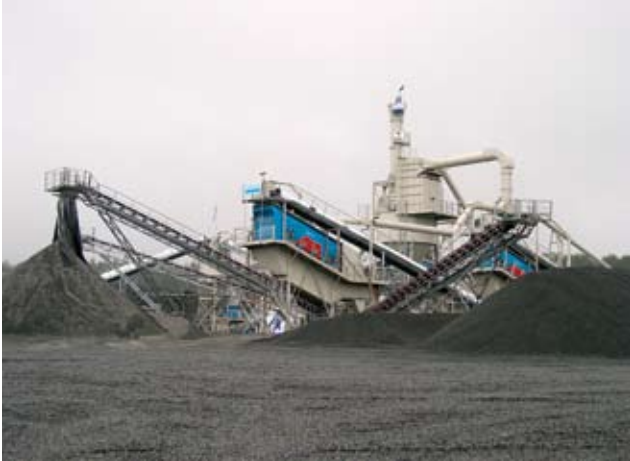
9 Semimobile Aufbereitung in Russland (Basalt AG) Semi-mobile preparation plant in Russia (Basalt AG)
