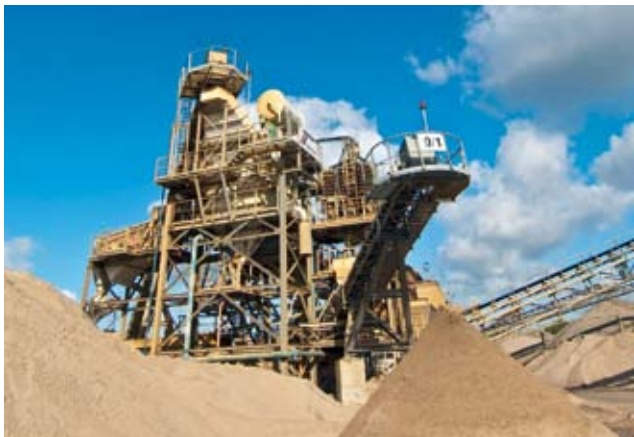
7 Kiesaufbereitungsanlage von Cemex (Cemex Deutschland) A Cemex gravel preparation plant (Cemex Germany)
