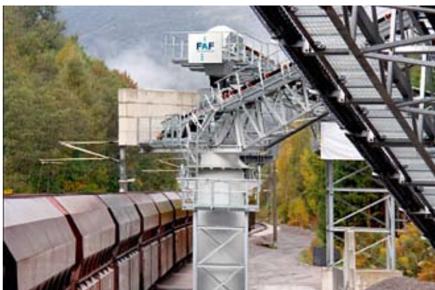
23 Bahnverladeanlage in Tirol (FAF Fördertechnik) Rail loading facility in Tirol (FAF Fördertechnik)
